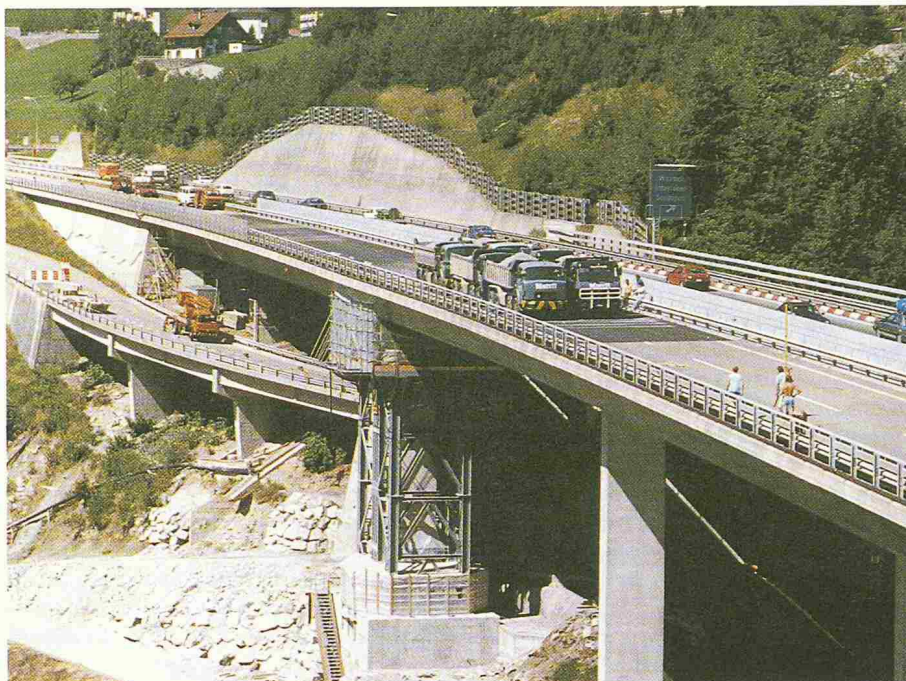
Bild 14. Belastungsversuch mit 6 Vierachs-Lastwagen am 11. Juli 1988 A. von Glutz
