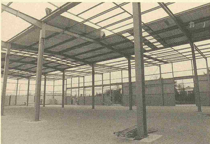
Fabrikhalle in Bremen: vollständig demontabel und wiederverwertbar
