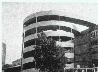
Rampe Parkhaus Migros Herdern
