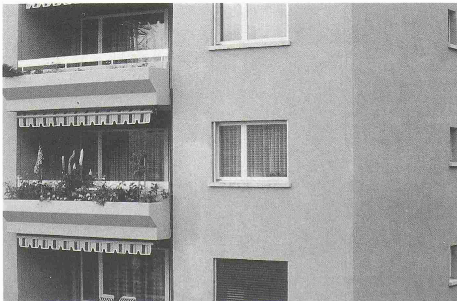
Bild 6. Kalkausblühungen (weisse Flecken) an der Deckputzoberfläche eines mineralischen Putzes mit einem Mineralanstrich. Die Ausblühungen sind eine Folge der zu hohen Mauerfeuchtigkeit vor den Verputzarbeiten
