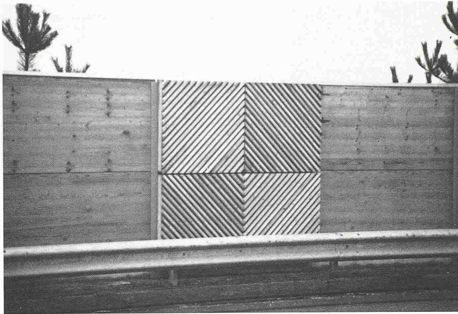
Bild 3. Pilotobjekt einer Lärmschutzwand aus druckimprägniertem Weisstannensperrholz in der Nähe von Kölliken. Die Qualität der Sperrholzplatten und der verschiedenen Abdeckungen werden von der Abteilung Holz der EMPA periodisch geprüft
