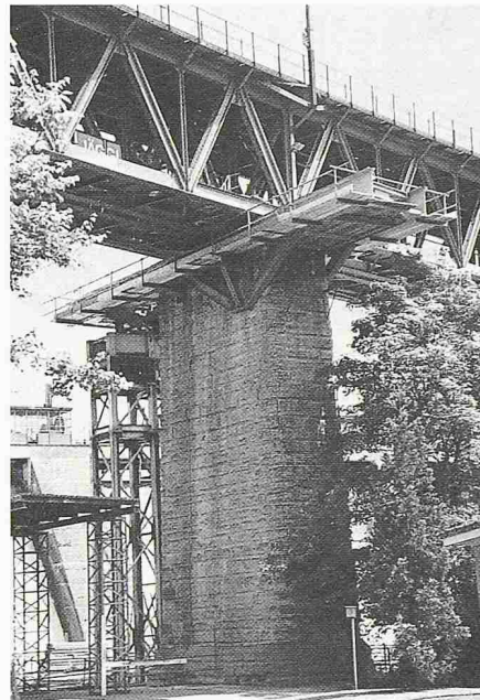
Bild 5. Der Pfeiler auf Seite Wettingen mit fertig installierter Doppelverschubbahn. Abstützung auf Pfeiler und Gerüsturm
