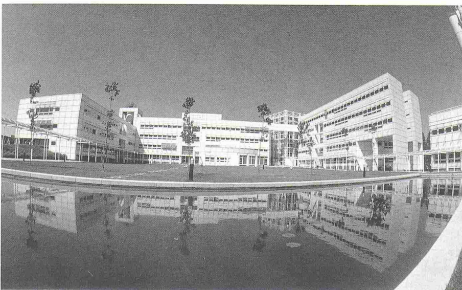
Gesamtansicht des neuen Gebäudekomplexes des Centre de Recherches du Gaz de France (Bild: F. Frichet)
