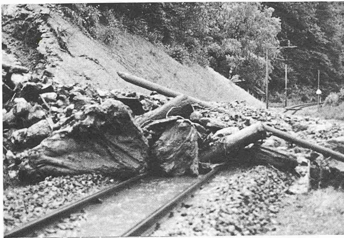
Bild 4. Mit Baumstämmen, Felsbrocken und Geröll hat der Husergraben-Bach bei Lungern 1986 das Bahngleis verschüttet
