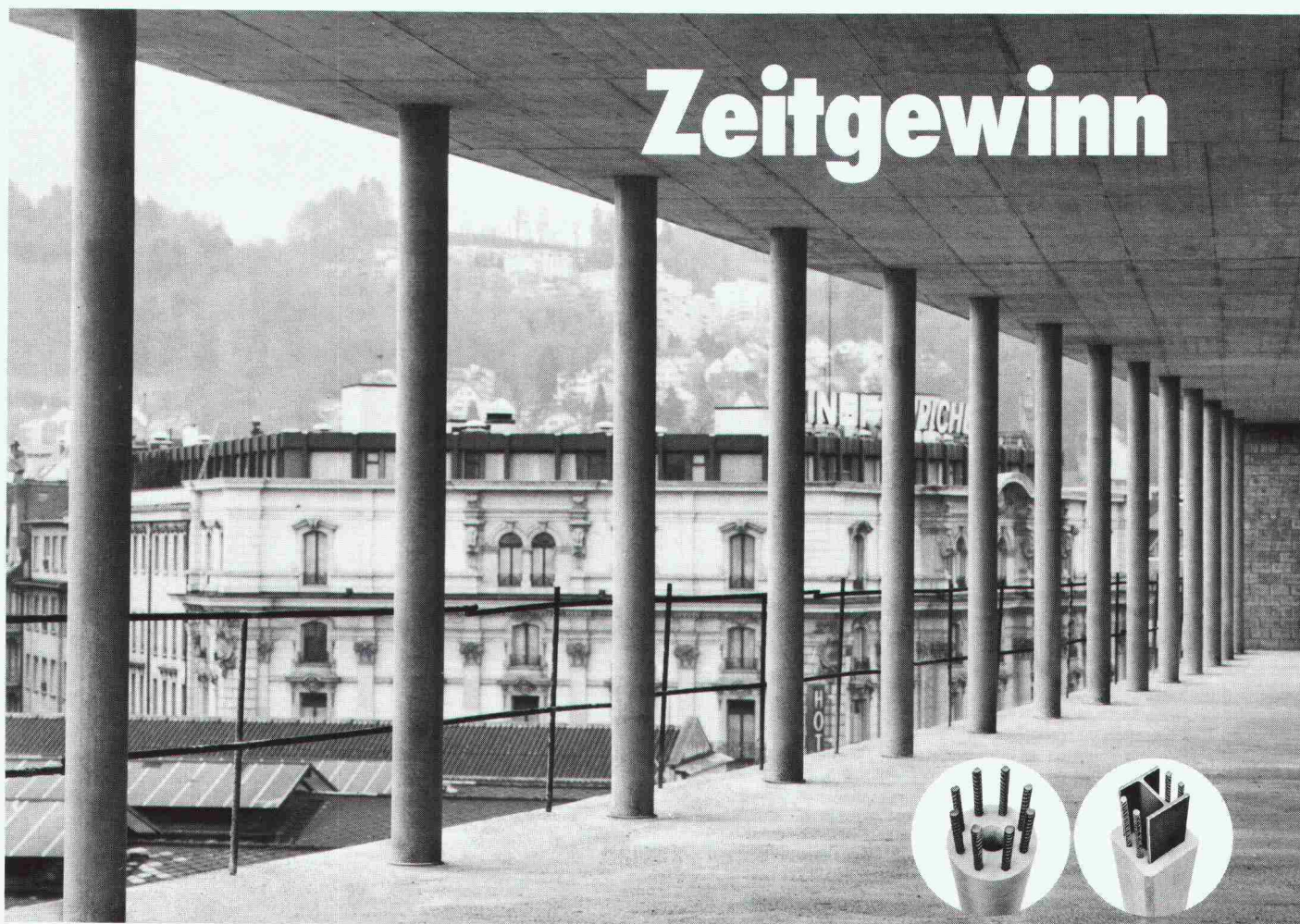
Neubau Bahnhof Luzern
