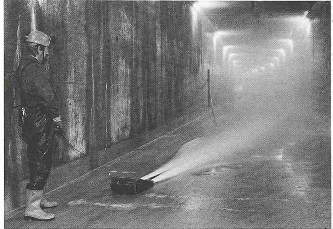
Bild 8. Schwingdüse zur Reinigung des Zulaufkanales
