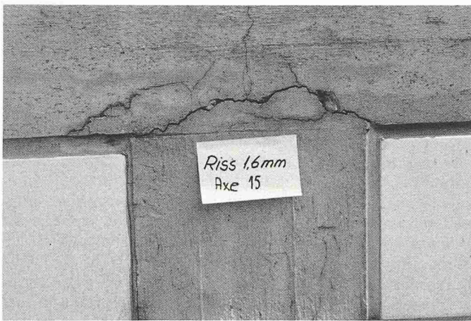
Bild 5. Verformungsriß im Übergang Stütze-Decke. Spannweite l = 13,2 m; Deckenstärke d = 35 cm \triangleq 1/38 ; Durchbiegung \delta = 50 mm \triangleq 1/270 . Baujahr 1966
