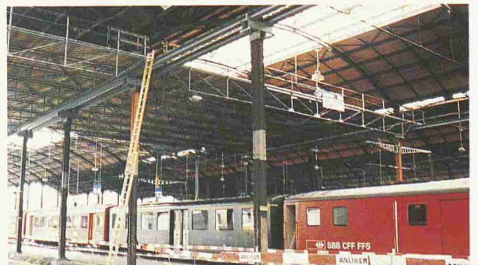
Bild 3. Schutz- und Arbeitsbühne über den Gleisen
