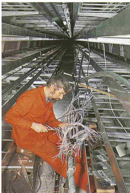
Bild 3. Monteur beim Spleissen eines Fernmeldekabels 100 \times 4 \times 0,6 im Kabelstollen
