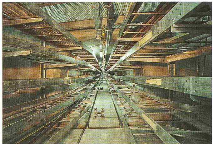
Bild 2. Blick in den Kabelstollen (Montagezustand)
