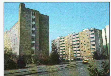
▲ Belgien: Sozialer Wohnungsbau, Gent. (Sanierung)
