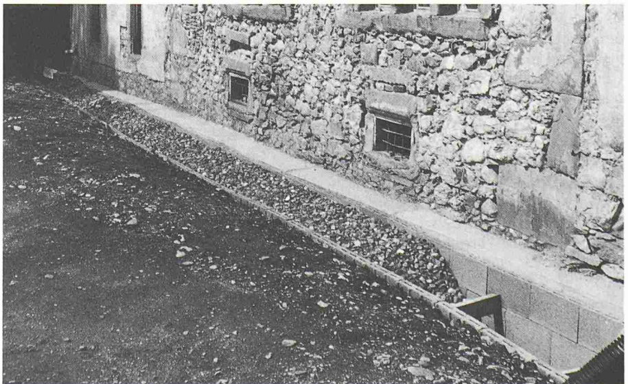
Bild 23. Dieselbe Mauer nach der Sicherung mit Fließbeton (Bindemittel Hydraulischer Kalk HK). Sickerplatten, Sickerpackung und Drainage schützen vor Feuchtigkeit. (Winkelriedhaus Stans 1987)
