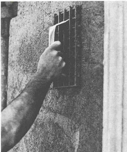
Bild 8. Der Rabot ist eines der möglichen Hilfsmittel, um die Sinterhaut nach dem «Anziehen» des Mörtels zu entfernen
