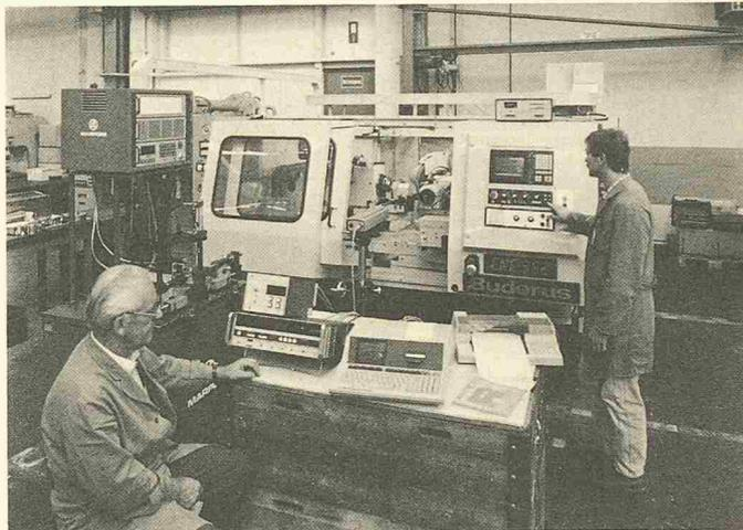
Die Qualitätssicherung von Werkzeugmaschinen der Asea Brown Boveri AG, Baden-Dättwil, ist eine der wenigen vom Eidgenössischen Amt für Messwesen anerkannten Kalibrierstellen. Dieses Team, spezialisiert für das Messen der Geometrie und des Einfahrverhaltens an Werkzeugmaschinen mit einer Messunsicherheit von plus/minus einem Hundertstelmillimeter pro Meter, stellt ihre Dienste, unter anderem mit Laser-Interferometer, nebst den eigenen Fabrikationsstätten auch Fremdfirmen zur Verfügung.
