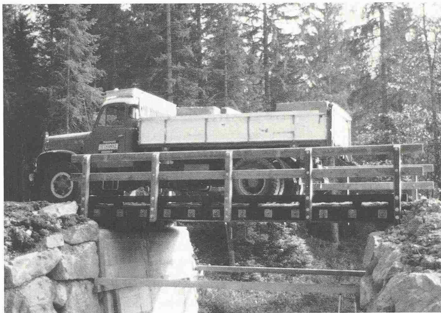
Bild 3. Brücke für Walderschliessungsstrassen
