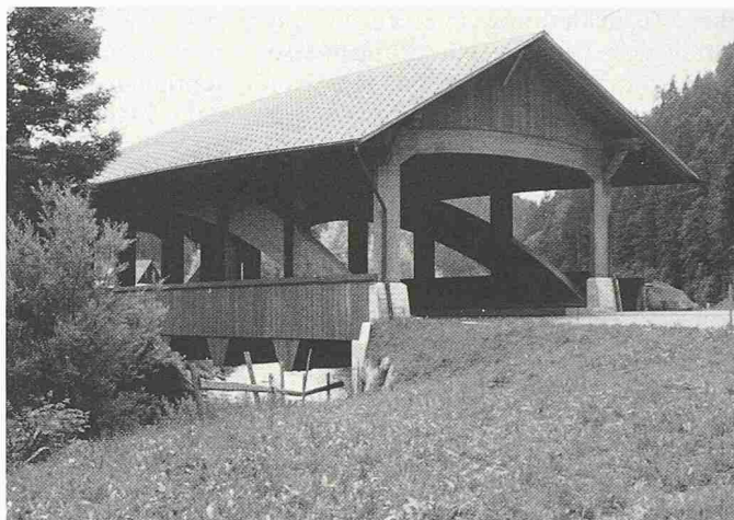
Bild 2. Strassenbrücke in Eggiwil
