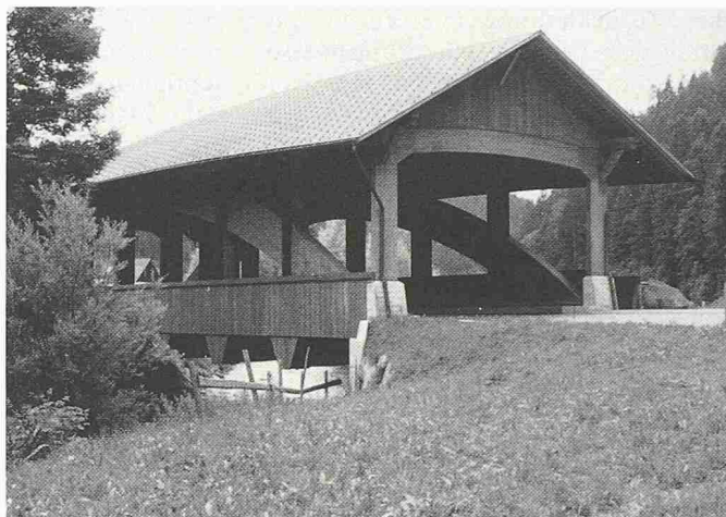
Bild 2. Strassenbrücke in Eggiwil
