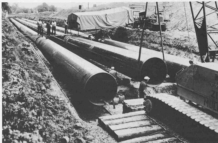
Der grösste unterirdische Erdgas-Röhrenspeicher bei Aarau im Bau. In drei 400 m langen Stahlrohren werden ab November rund 136 000 m 3 Erdgas gespeichert (Foto H. Fröhlich, Aarau)
