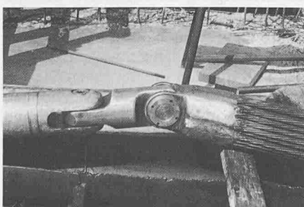
Bild 7. Schrägseilkabelende mit eingeschweisstem Gelenkstück für Installation
