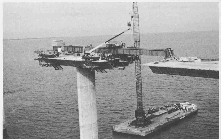
Bild 9. Balanced-Cantilever-Verfahren mit Plattenträger und Beam & Winch
