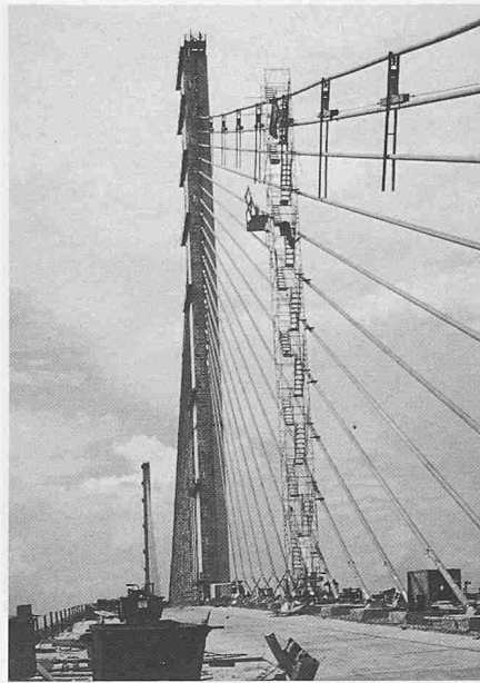
Bild 8. Installierte Schrägseilkabel mit Gerüsturm für das Zusammenschweissen der Hüllrohre
