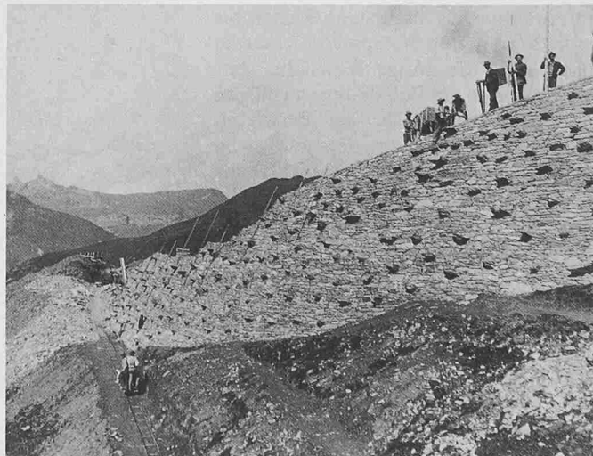
Stützmauerbau auf dem Eigergletscher
