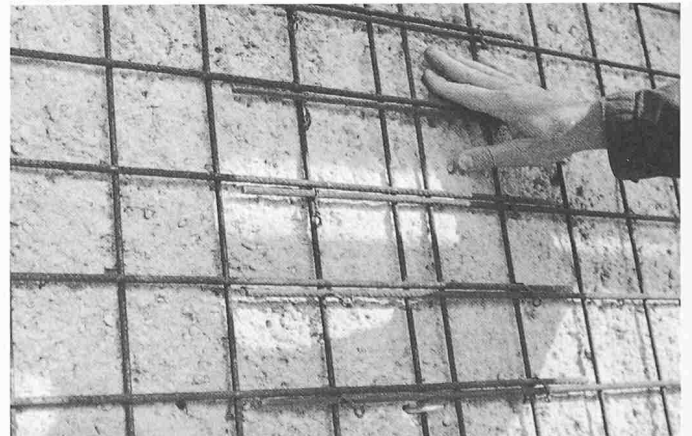
Bild 24. Stahldrahtnetz als Armierung von Spritzbeton. Verstärkung einer Si-lowand
