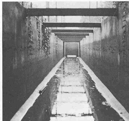
Bild 19. Mit Spritzbeton ausgekleideter Kraftwerkkanal. Reparatur und Abdichtung
