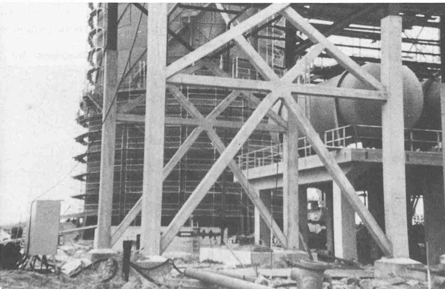
Bild 5. Mit Spritzbeton ummantelte Stahlkonstruktion einer Raffinerie, Brandschutz (Foto Torkret GmbH, Essen)
