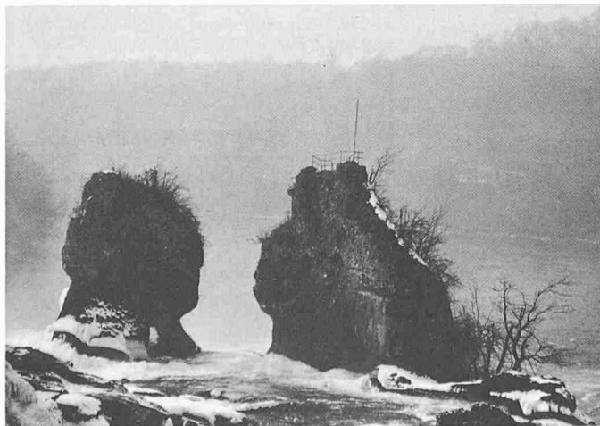
Bild 15. Mit Spritzbeton konsolidierte Felsen des Rheinfallles bei Schaffhausen. Erosionsschutz
