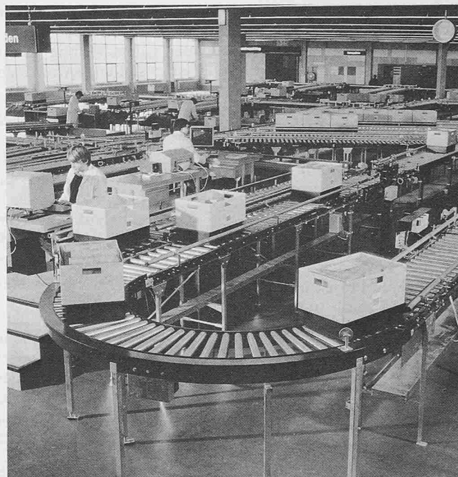
Bild 13. Als Subsystem übernimmt jede Förderanlagensteuerung einen Teilbereich einer solchen Anlage. Hier sind die Behälter codiert und werden mit Laser-Scannern in ihrem Bewegungsablauf überwacht
