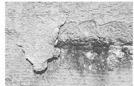
Bild 3. Aufgeplatzte Betonoberfläche.
