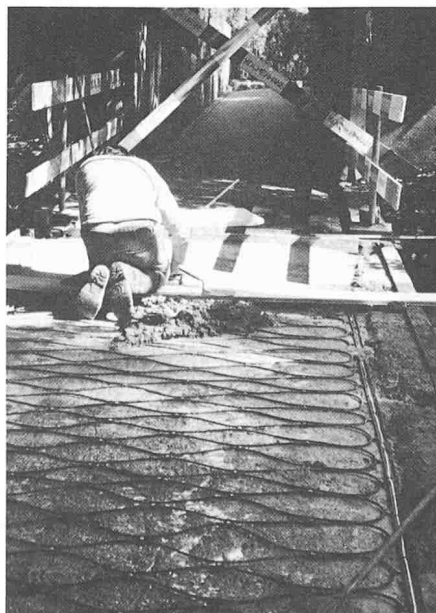
Bild 5. Aufbringen der Überdeckung auf das Anodennetz
