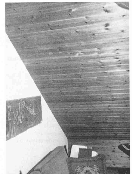
Bild 2. Normalaufnahme der Raumecke von Bild 1
