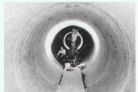
Hier werden Stossfugen am Kabelschacht unter den Geleiseanlagen des Bahnhofs Luzern für einen sicheren Betrieb hundertprozentig abgedichtet.
