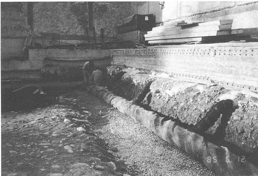
Bild 4. Ringdrainage (Sickerbetonstreifen, Längsdrainagerohr und Quersaugrohre mit Filtergewebeummantelung)
