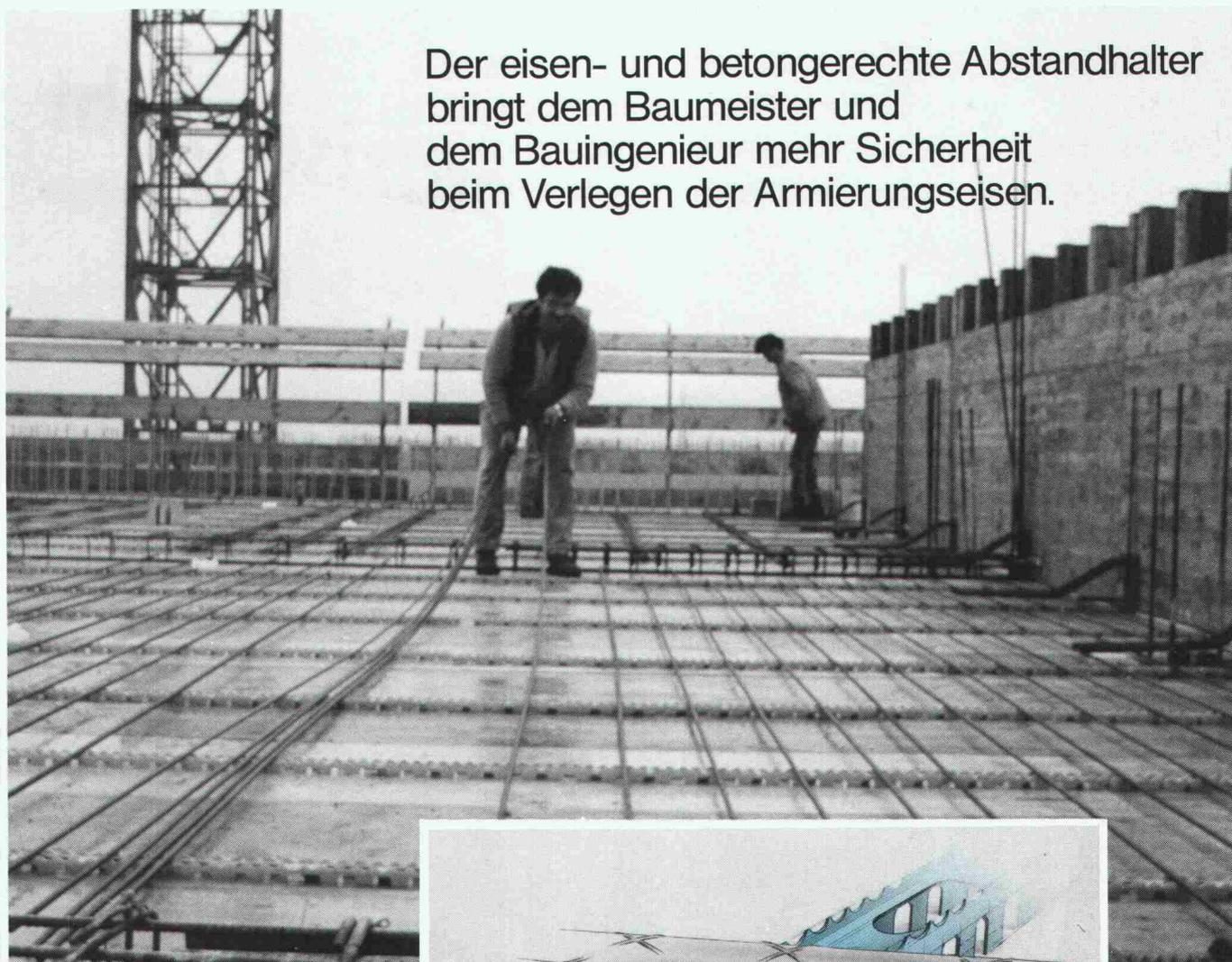
Der eisen- und betongerechte Abstandhalter bringt dem Baumeister und dem Bauingenieur mehr Sicherheit beim Verlegen der Armierungseisen.
