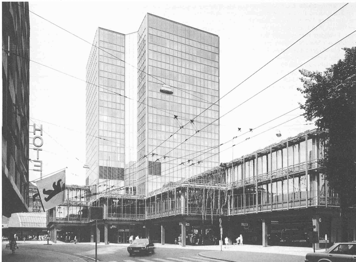
Blick von der Poststrasse auf das Rathaus
