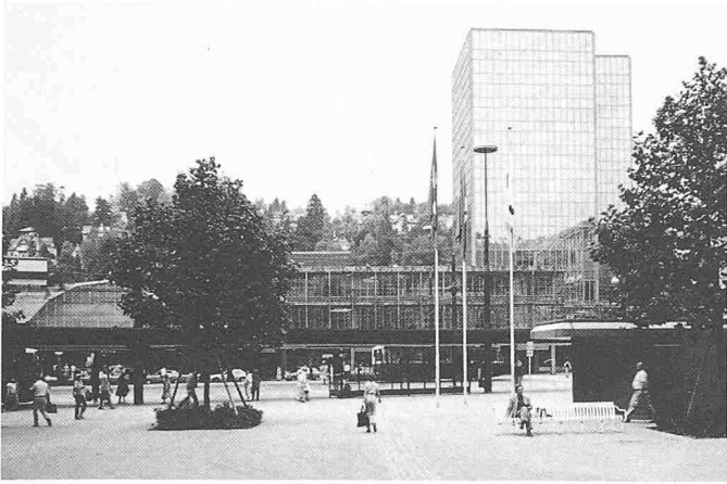
Gesamtansicht des Bahnhofplatzes mit Rathaus und Bahnhofzwischenbau
