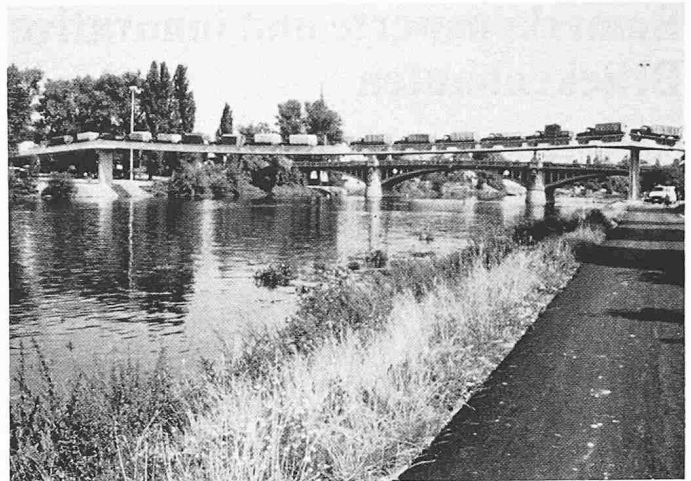
Bild 9. Spannbänderbrücke in der CSSR bei der Probelastung
