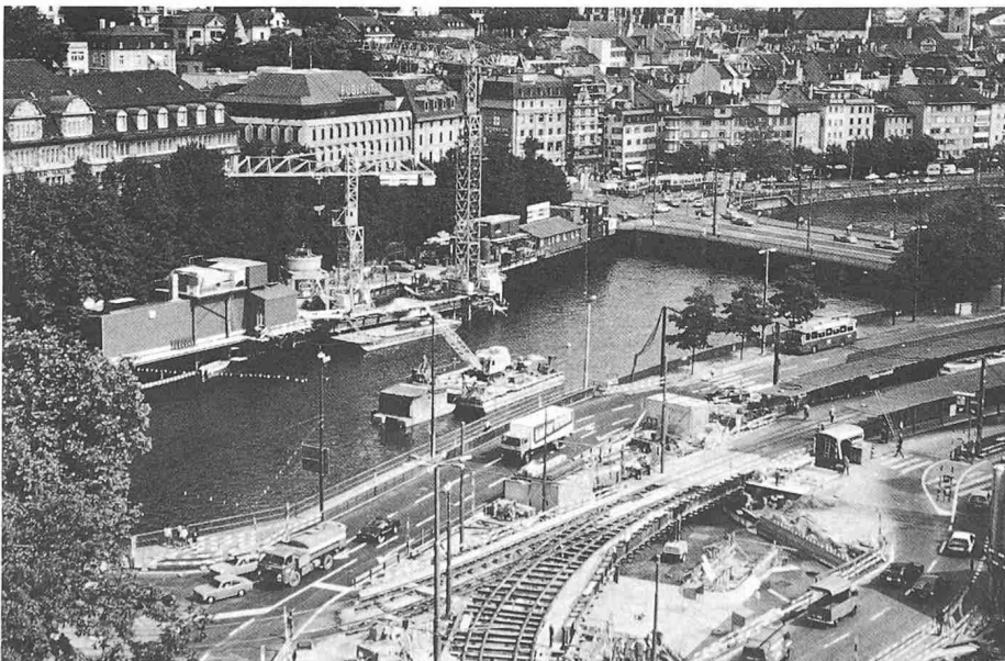
Bild 3. Baustellen am Bahnhofquai und in der Limmat
