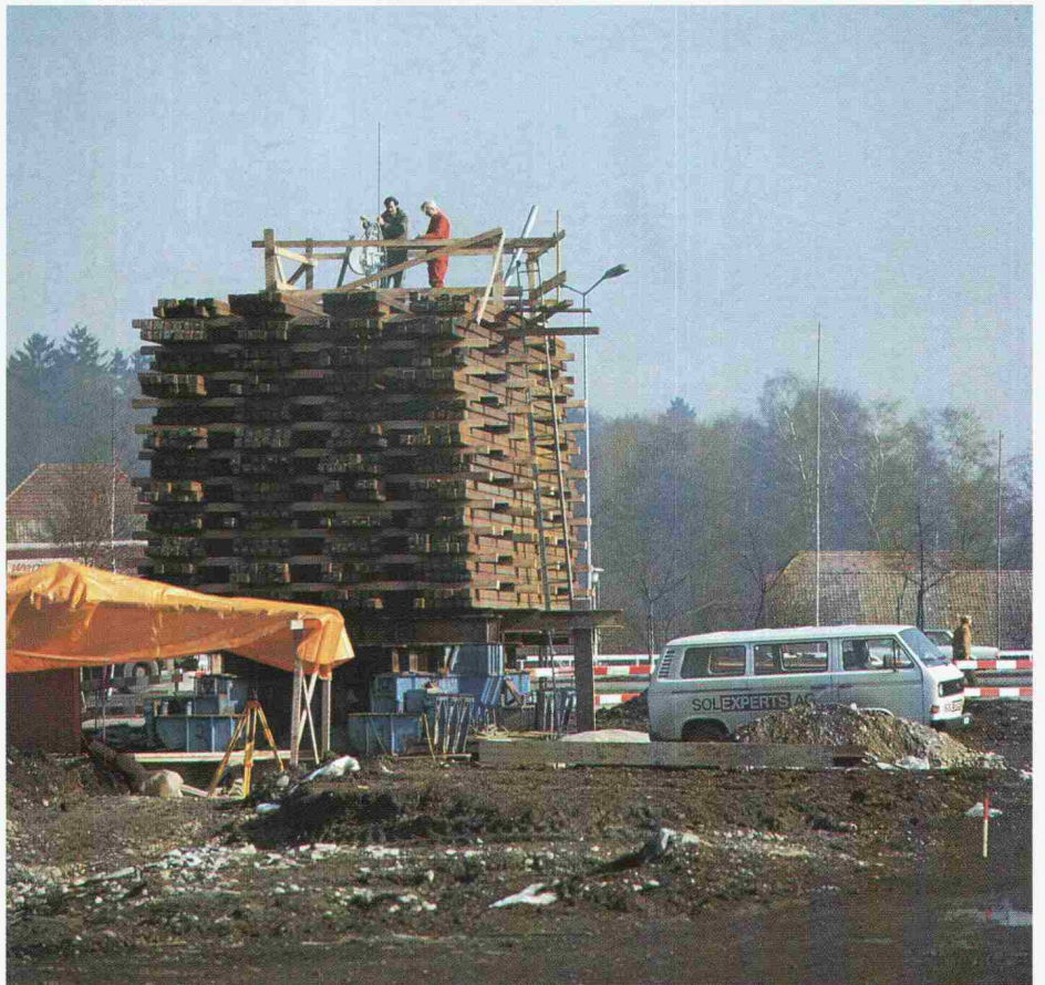
Pfahlbelastungsversuch Viadukt Neugut
