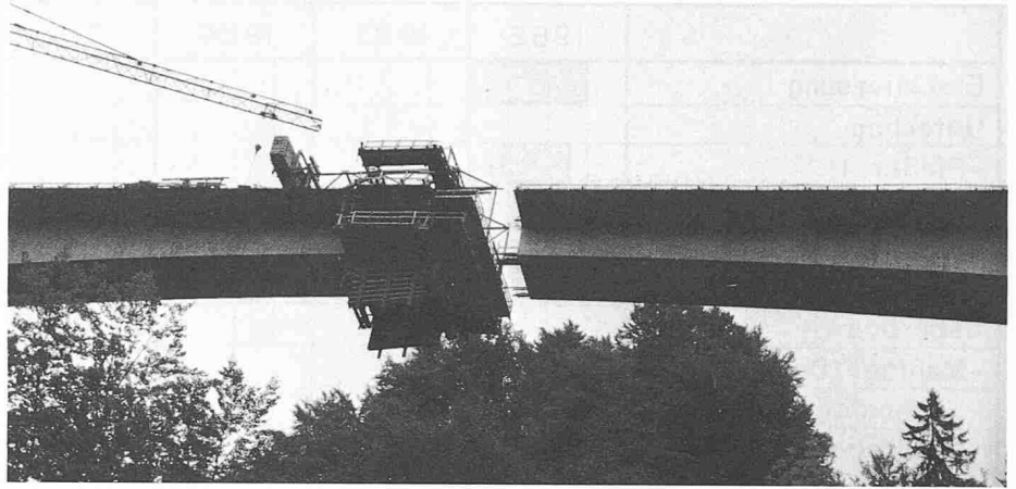
Vor Fugenschluss S2/S3
