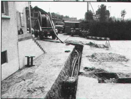
FLEXWELL-Leitungen von der Rolle in den Graben
