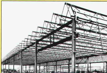
Metallstruktur eines Fabrikgebäudes mit Mini-Sheddach
