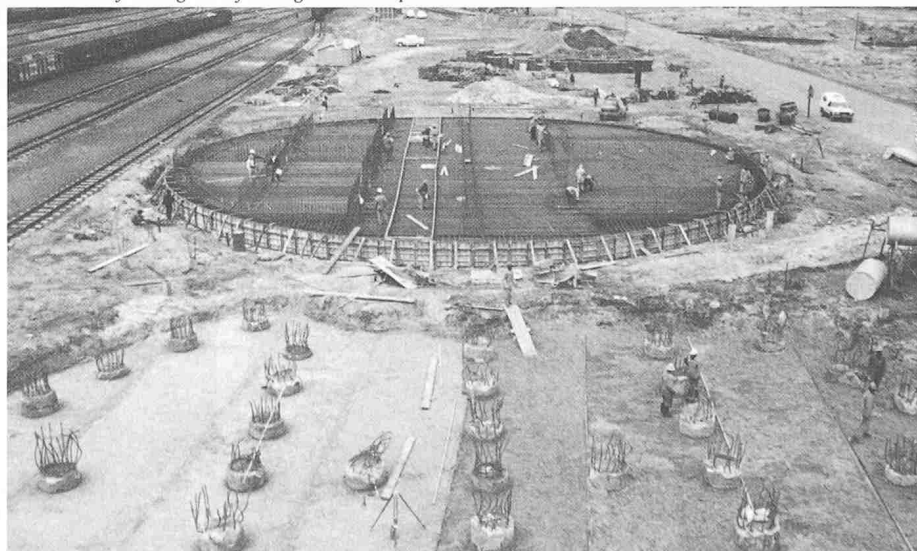
Bild 2. Ausführung von Pfählung und Bodenplatte
