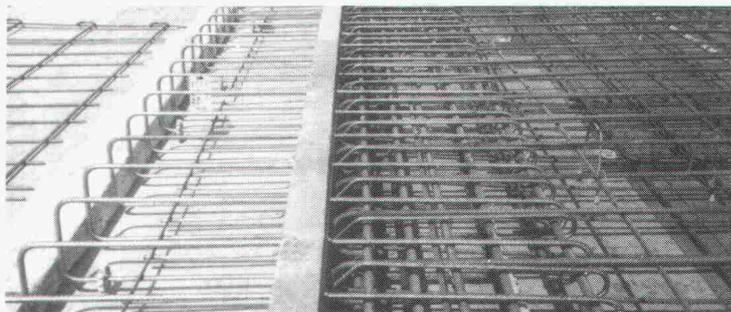
**ebea**® Kragplattenanschlüsse aus Ripinox erhöhen die Sicherheit
