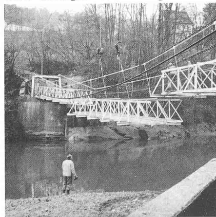
Bild 4. Einhängen zwischen den Trageisen
