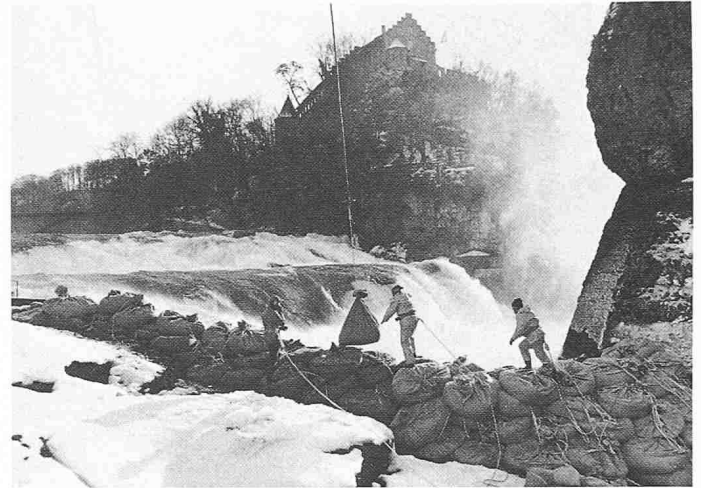
Bild 5. Nachabdämmung oberhalb des kleinen Felsens (Foto Max Baumann, Schaffhausen)
