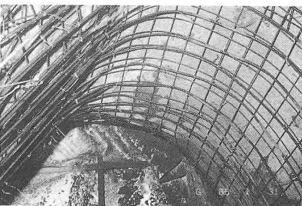
Bild 8. Spritzbeton-Netzarmierung mit Verstärkung am Hohlraumscheitel des kleinen Felsens (Foto Gubler, Laich SA)
