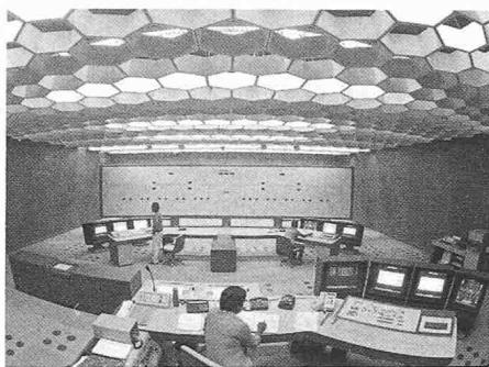
Bild 10. Kontrollraum mit SCADA-8-Steuerungsanlage
