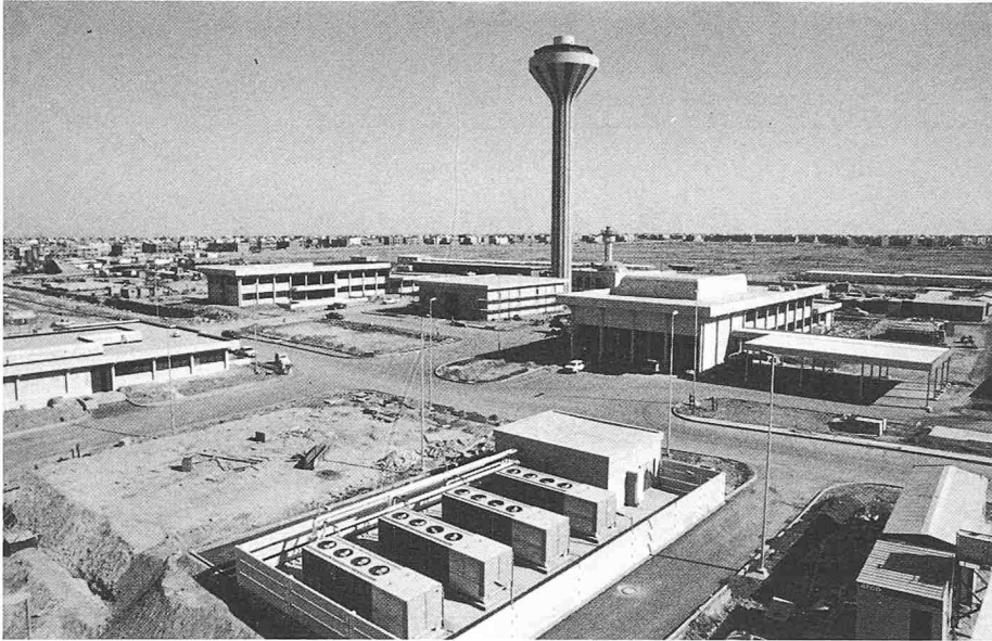
Bild 14. Zentraler Bereich mit Administration und Wasserturm
