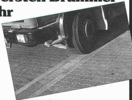
Faserfix Super-Ablaufrinnen aus Glasfaser-Beton mit dem grossen Anwendungsbereich für:
