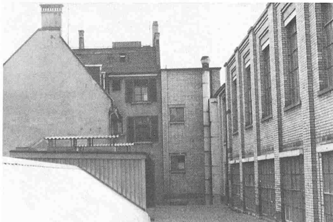
Reishauertrakt mit Blick gegen Wohnhaus Konradstrasse. Diese Fassade bleibt im Innern des Neubaus erhalten
