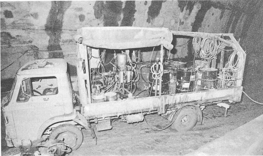
Bild 4. Mobile PU-Injektionsanlage
