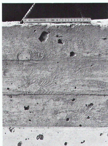
Bilder 1 + 2: Links Beispiel der bis anhin üblichen Innenflächen von Brückenbrüstungen mit starker Lunkerbildung. Rechts ein gleiches Element, dessen Innenschalung mit einer Vliesmatte abgedeckt war.
