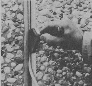
mechanischen Einwirkungen, Feuchtigkeitsschutz und Wärmeisolierung auf. Tegufil PE ermöglicht eine konvexe Begrenzung der Fugentiefe und dient somit auch als Formgebungshilfe für die Fugendichtungsmasse. Es ist chemisch neutral gegenüber Silikonen, Polysulfiden, Polyurethanen und Polyacrylaten.
