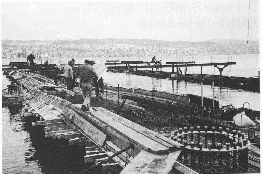
Bild 16. Bau der Schiffsliiftstege
