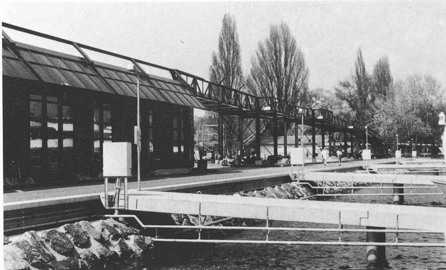
Bild 7. Uferböschung mit Alpenkalk-Blocksatz, vorgefabriziertem Versorgungskanal und Hafenstegen. Dahinter die Fassade des Betriebsgebäudes und der Seeuferweg
