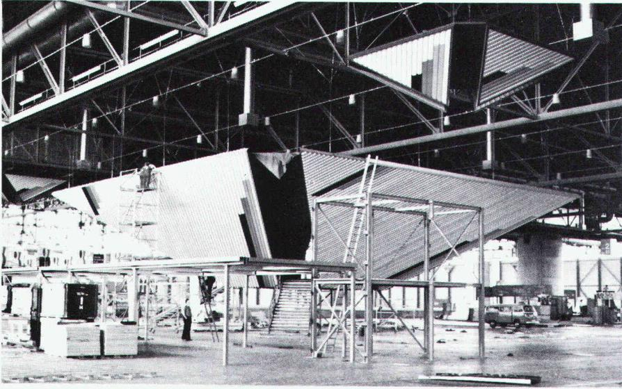
Gesamtansicht des Ausstellungsstandes der Bundesrepublik an der TELECOM 83 in Genf; die 30 Tonnen schwere Stahlstruktur mit etwa 1500 m<sup>2</sup> Verkleidungsblech wurde in 9 Tagen aufgerichtet.
