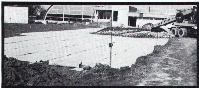
TREVIRA-spunbond wirkt als Trennschicht zwischen Untergrund und Strassenoberbau, als Filter bei Drainagen, Dammschüttungen und Böschungen.
