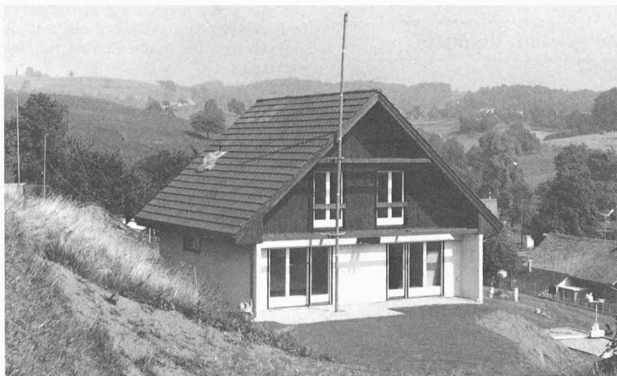
Bild 1. Messgebäude, Ansicht von Westen
