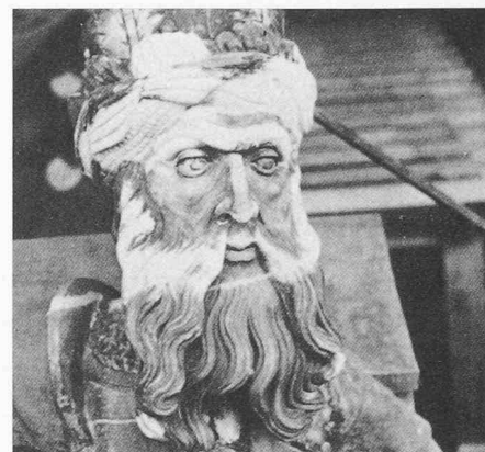
Kopf des Pannerträgers am Zinnenkranz der Marktplatzfassade. Die hellen Stellen sind neue Aufmörtelungen, in einem Sanierungsverfahren mit rein mineralischem Mörtel, der ähnliche Eigenschaften aufweist wie der Sandstein
