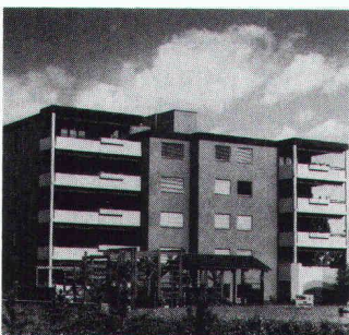
Foto: Peter Weber, BBI Bauberatung und Bauinformation
