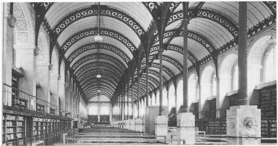
Bilder 43–44. Bibliothèque Sainte-Geneviève, Place du Panthéon, Paris 1843–50. Erster öffentlicher Bau mit schmiede- und gusseisernem Skelett, Kühnheit der Dimension
